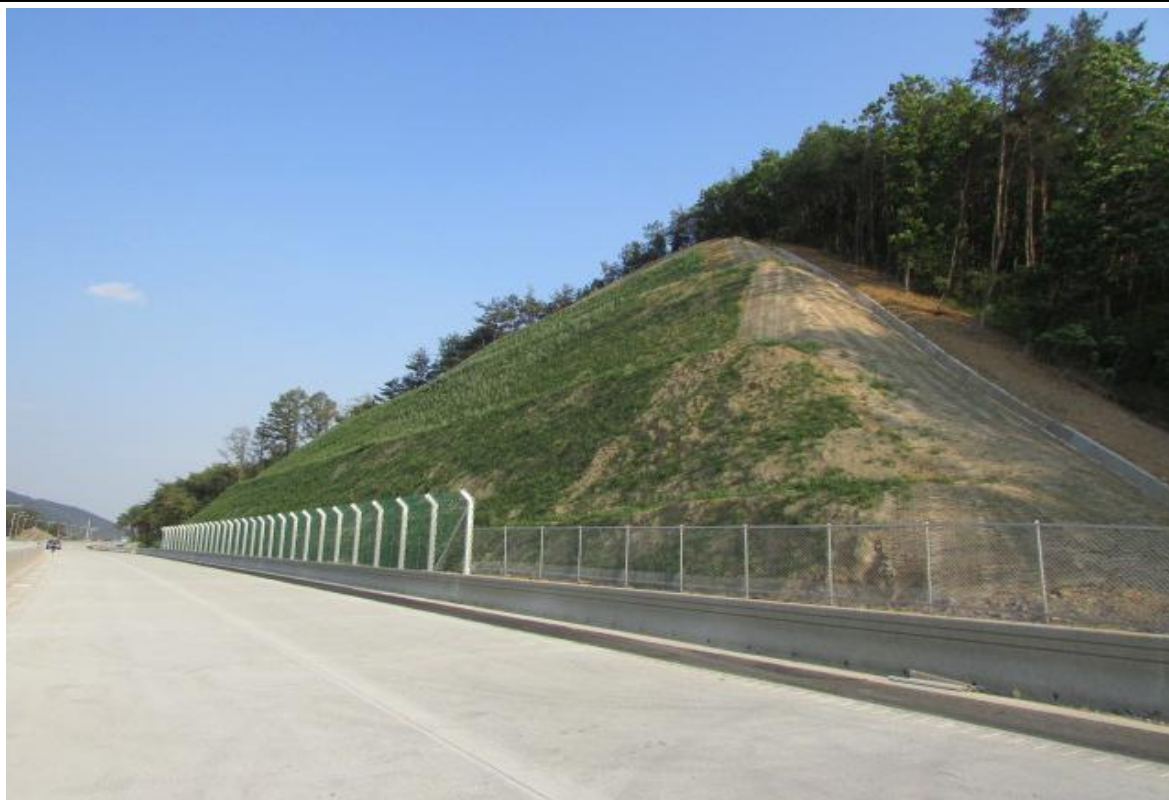
23. STA. 11+080 ~ 11+230 우안(영천방향) 비탈면
