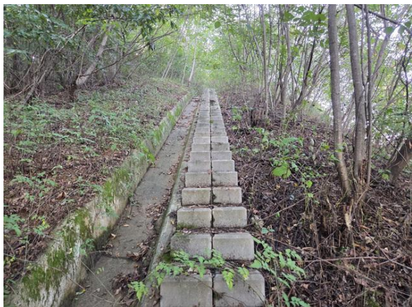
산마루측구, 점검계단 전경
